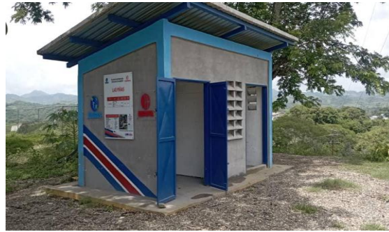
CUARTO DE CONTROL
