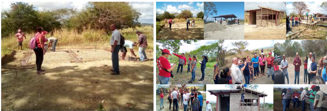
Actividades varias en proceso de construcción
